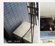
將主機吊起抬離地面,下面墊以「彈簧振動緩衝器」,利用彈簧 分散能量的特性,消耗掉大部分主機傳遞到地板的振動。
